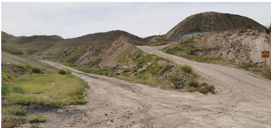
照片 8 矿山道路现状
