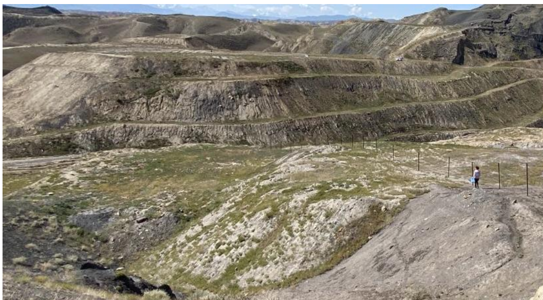
照片14 周边矿山治理恢复情况
