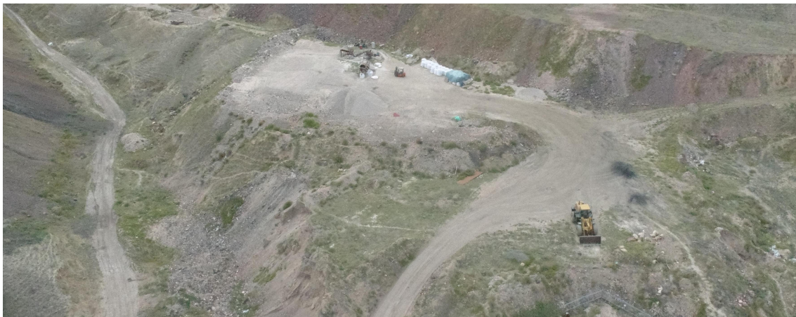
照片 4 排土场现状
