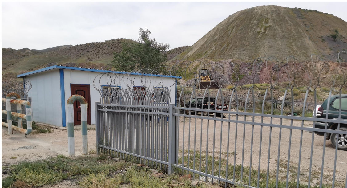
照片 6 矿部生活区现状
