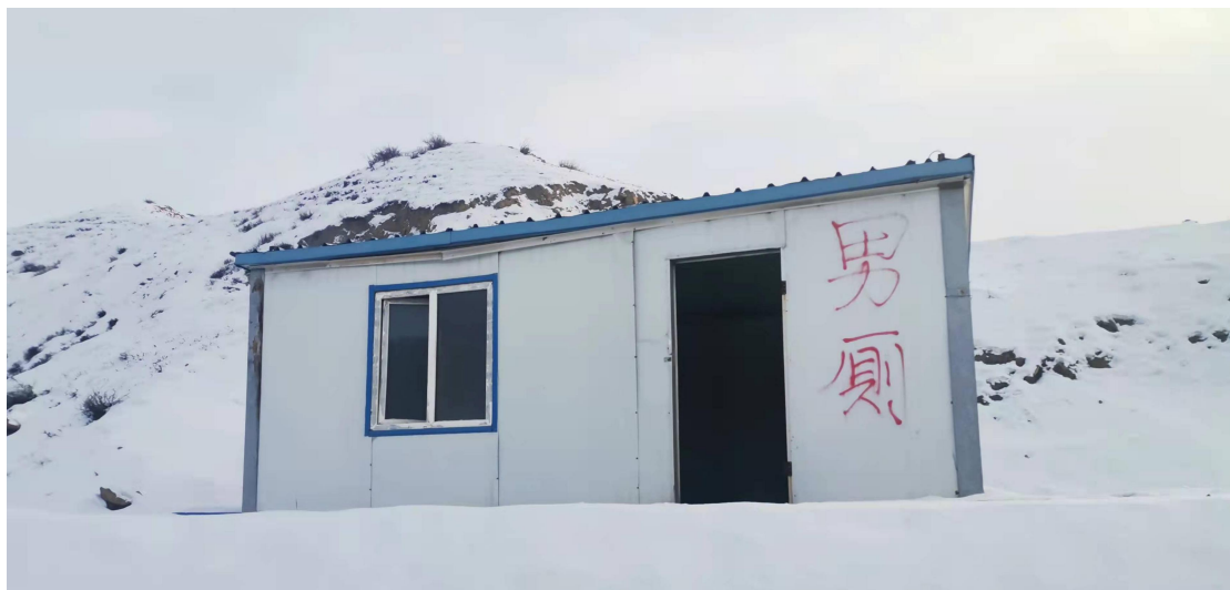
照片 7 矿区厕所
