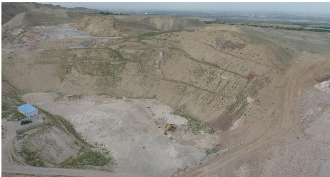
照片 1 矿山露天采矿场开采现状
