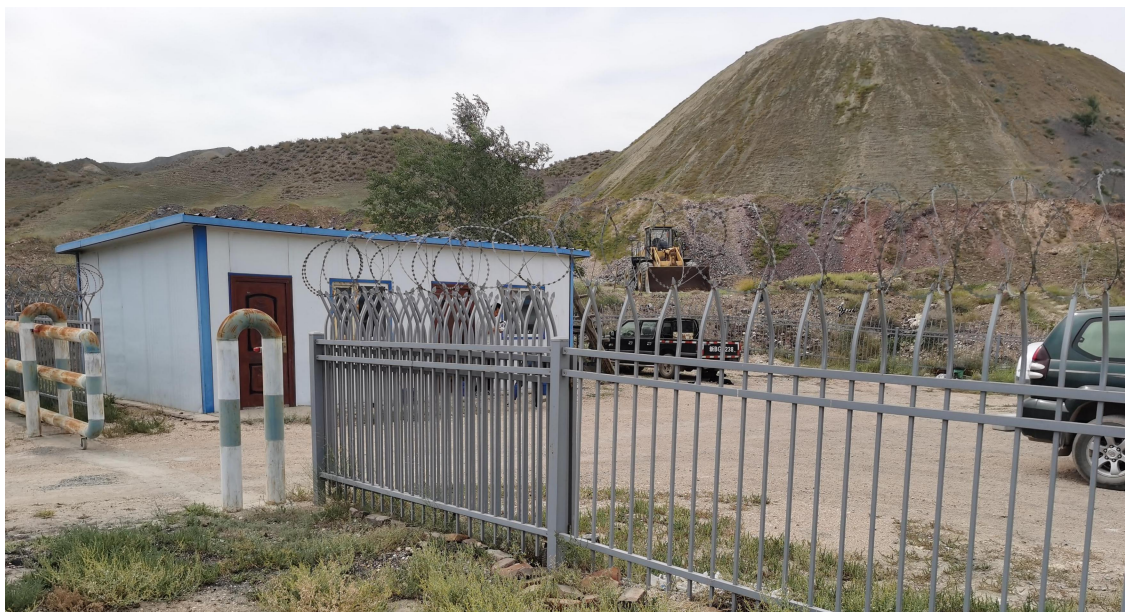
照片 6 矿部生活区现状
