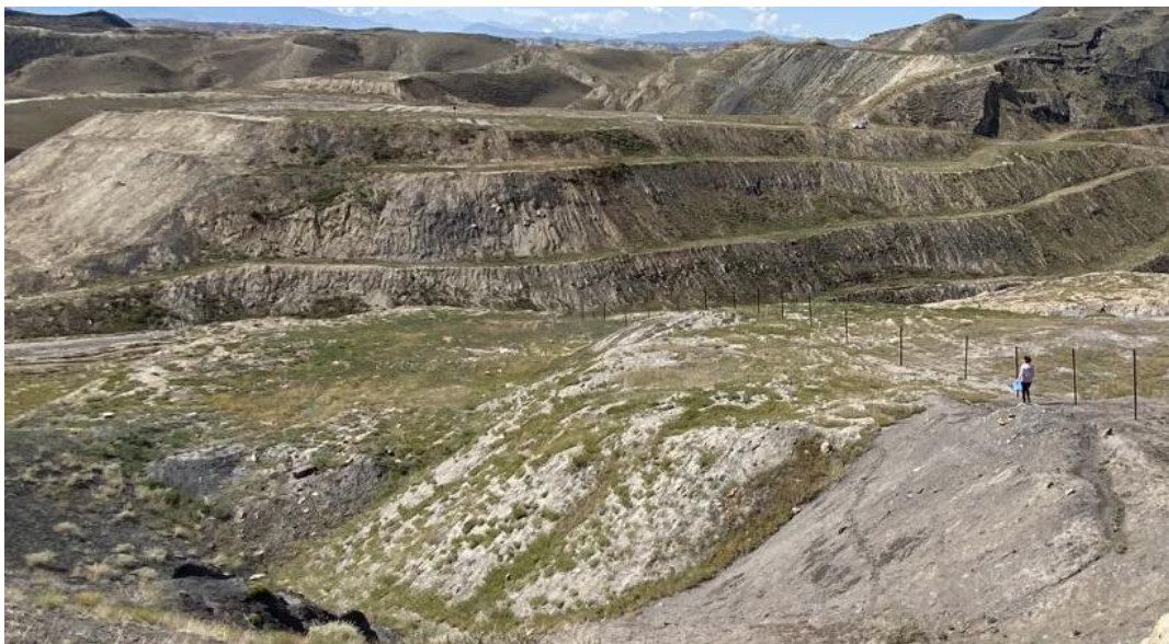
照片14 周边矿山治理恢复情况
