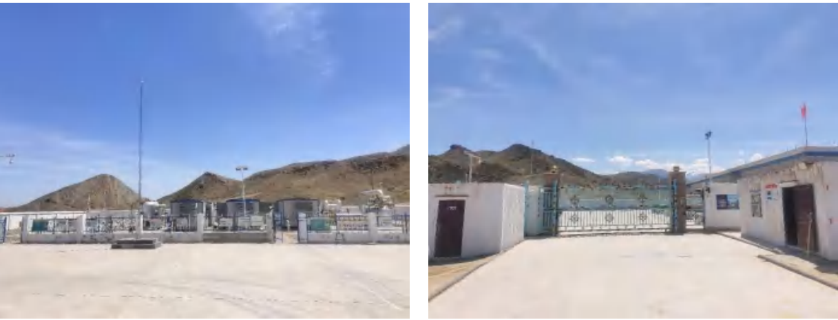
集气站现场照片
