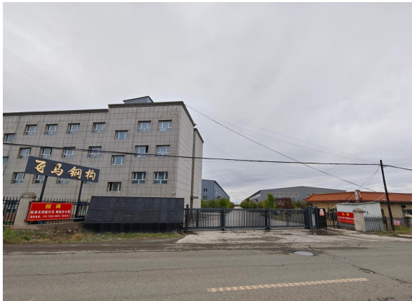
项目区东侧（园区道路）
