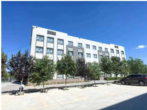
项目区现状（办公楼）
