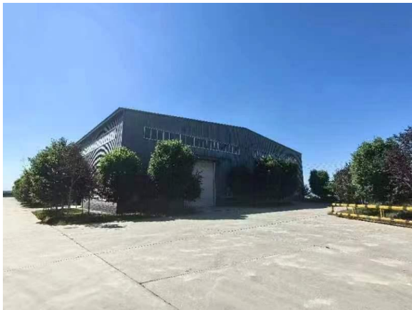
项目区北侧（厂区其他车间）
