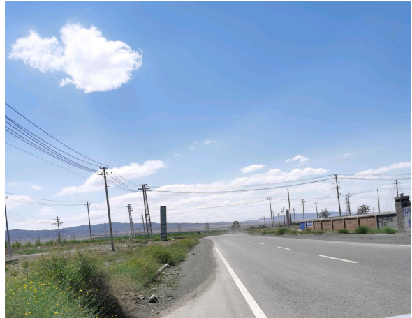
项目区南侧道路
