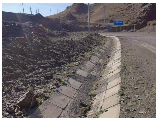
既有道路排水
