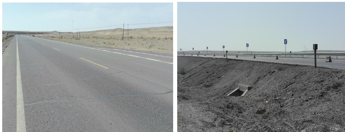
既有道路路面
