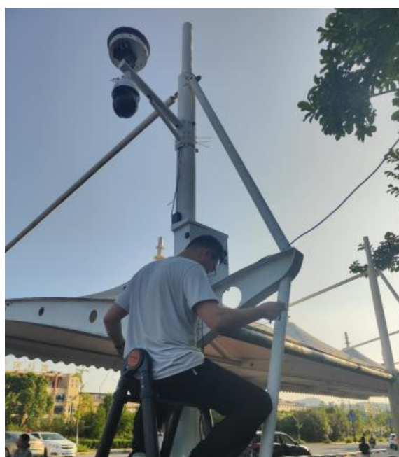
图 7-4 某市在考点加装声源识别系统
