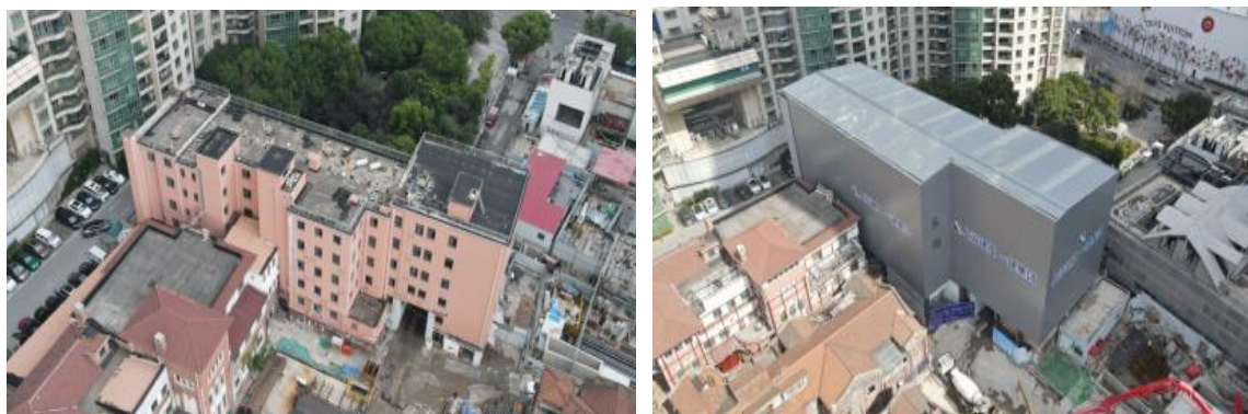
图 3-2 某施工工地采用全封闭覆盖法施工
