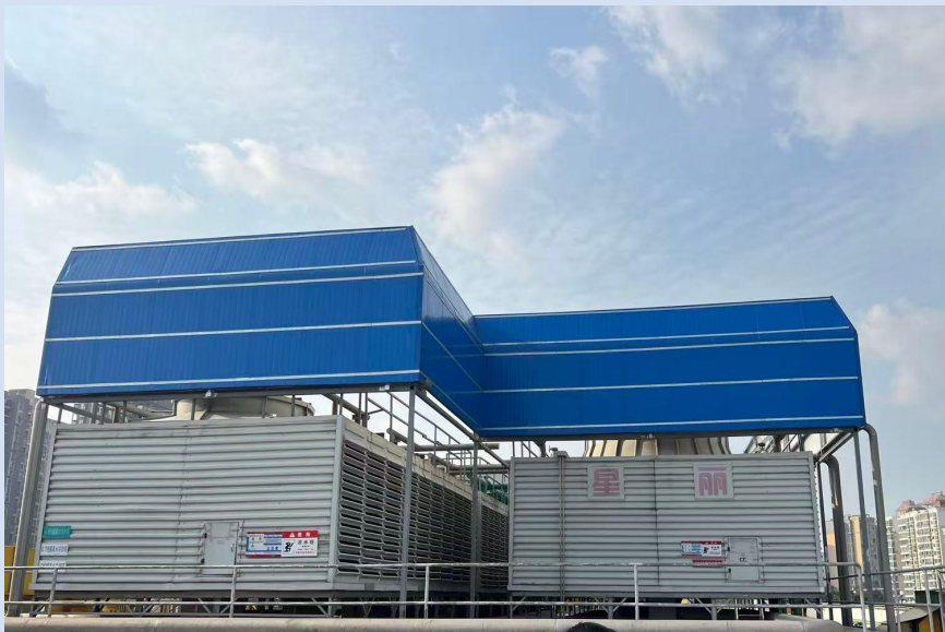
冷却塔加装声屏障
