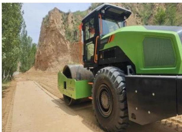
图 3-3 某施工工地使用的纯电动单钢轮压路机
