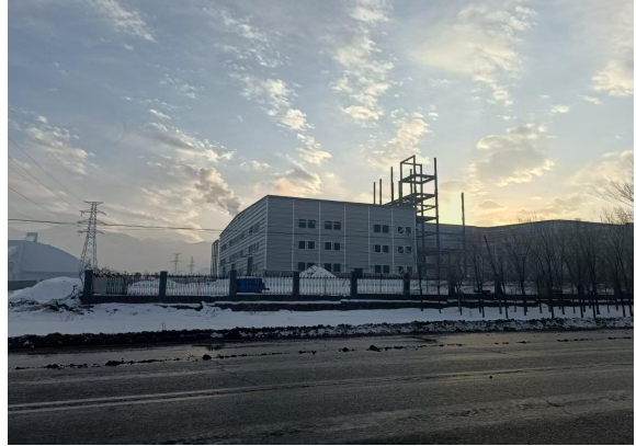
厂区西侧（新疆湘源新材料有限公司建设38万吨/年电解铝渣废弃物等综合利用项目）
