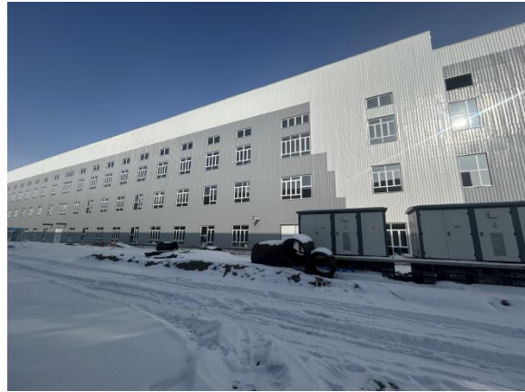
项目区北侧-孵化园道路、变电柜、空置厂房
