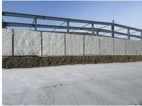
项目区西侧-孵化园道路、在建服务用房
