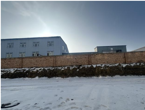
项目区南侧-孵化园道路、围墙
