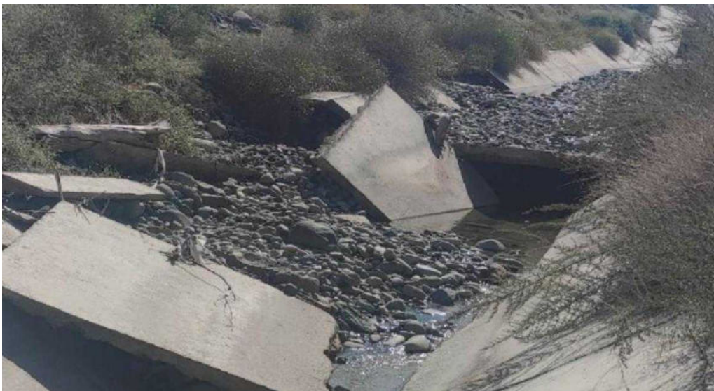
图4.3-5 四工河灌区五运支渠渠道现状
