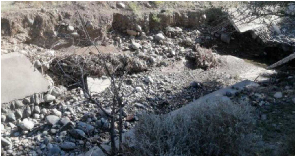
图4.3-4 四工河灌区五官梁支渠渠道现状
