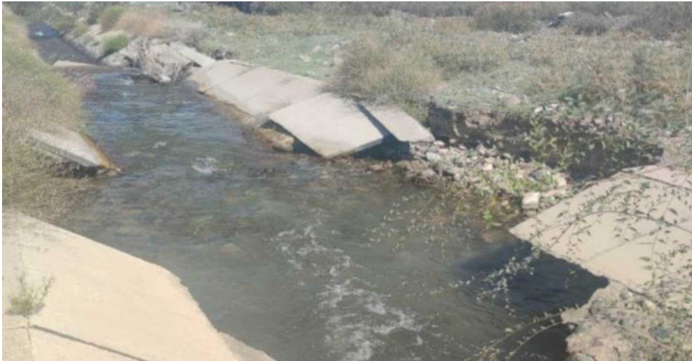
图4.3-3 四工河灌区西干渠渠道现状
