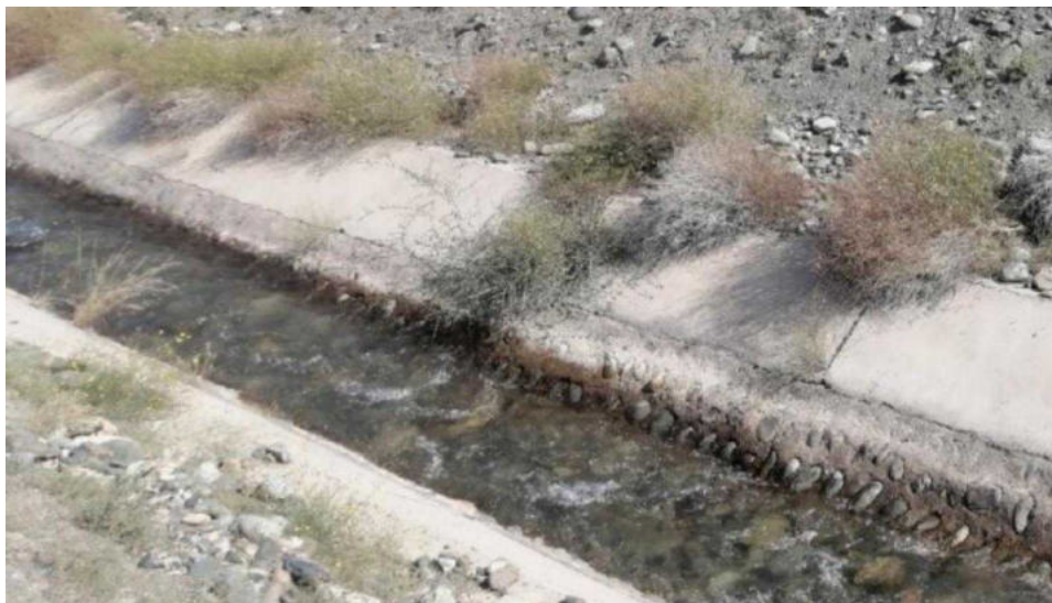
图4.3-2 四工河灌区东干渠渠道现状
