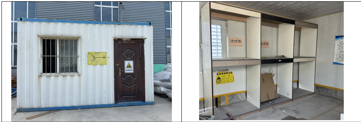
图 4-1 危险废物贮存库现状照片
