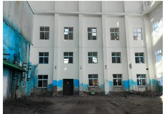
35t/h 燃气锅炉房现状
