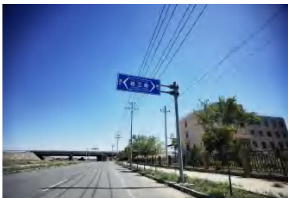
项目区东侧经三路
