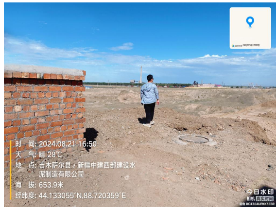
工程师现场勘察照片
