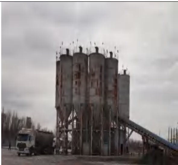
原有工程原料筒仓及除尘器
