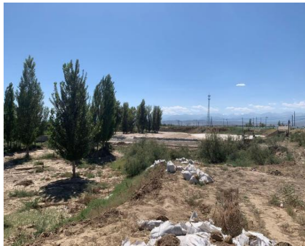
S303 至羊坝闸中小河流工程末端溢流堰现状
