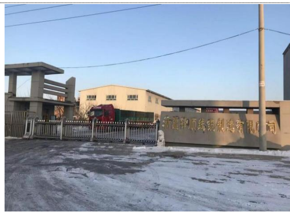
项目区西侧锋顺线缆
