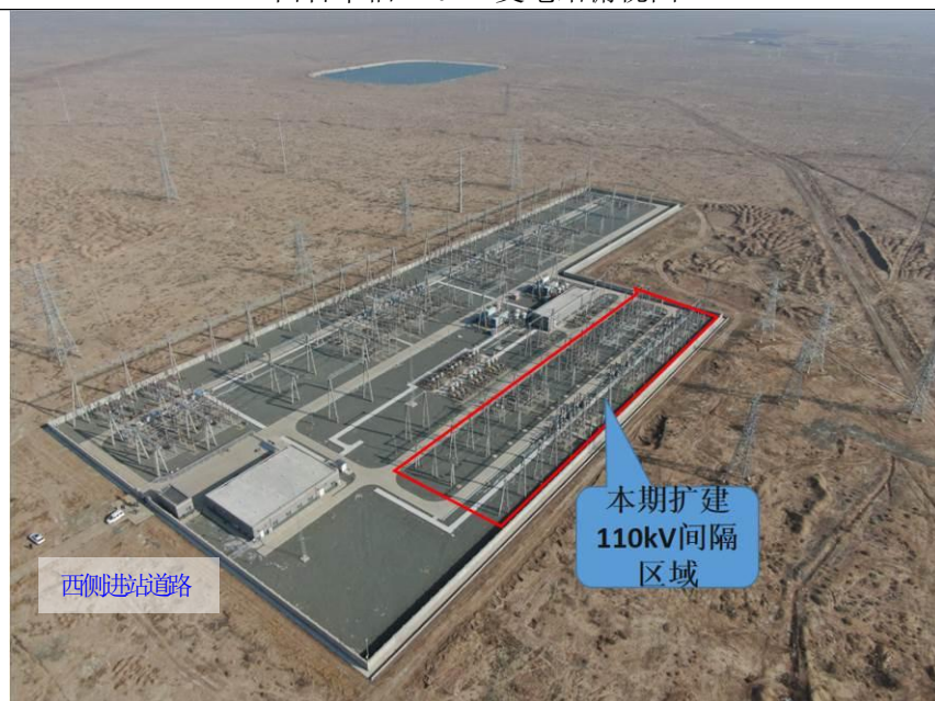
昌吉幸福 220kV 变电站现状
