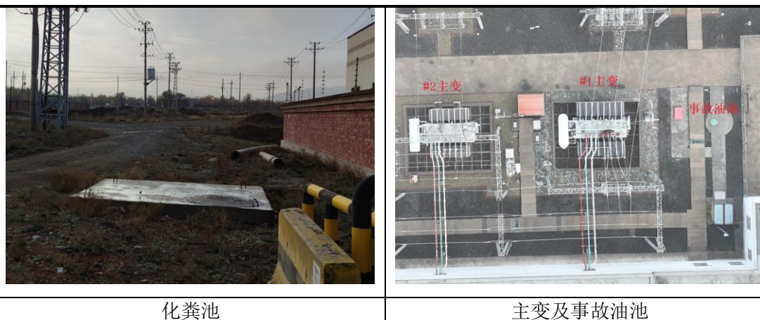
图 2 已建春光 110kV 变电站相关环保设施
