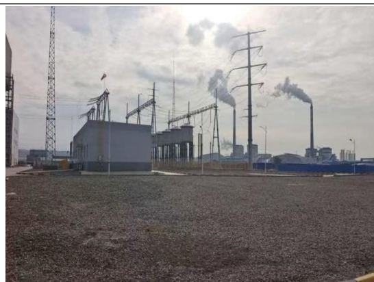
火电厂变电站
