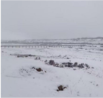
项目沿线现状
