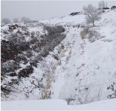
项目沿线现状
