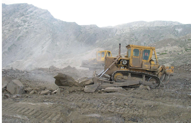
图 8 剥离平整施工
