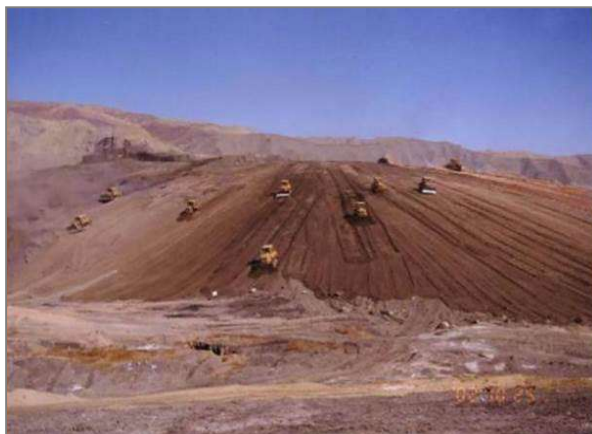
图 10 黄土覆盖施工
