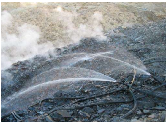
图 7 地表注水施工
