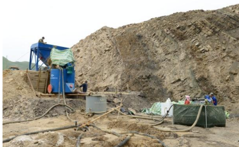
图 2.13.2-5 钻孔注浆图
