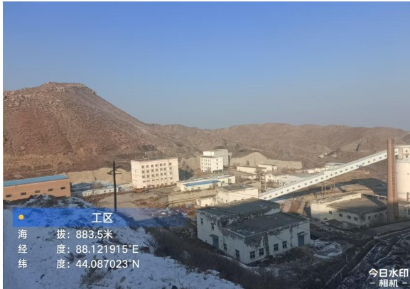
气煤一号井工业场地
