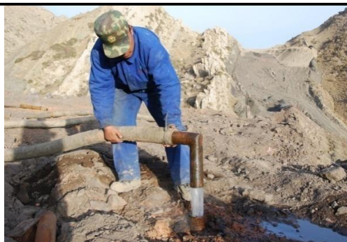
图 2.4-4 钻孔注水
