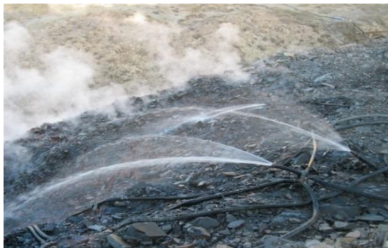
图 2.4-1 火区地表注水
