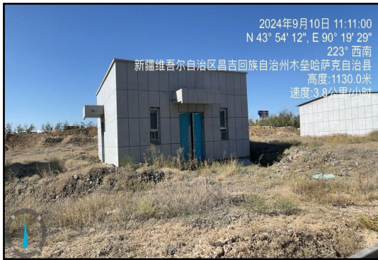
老厂区老厂房配电室
