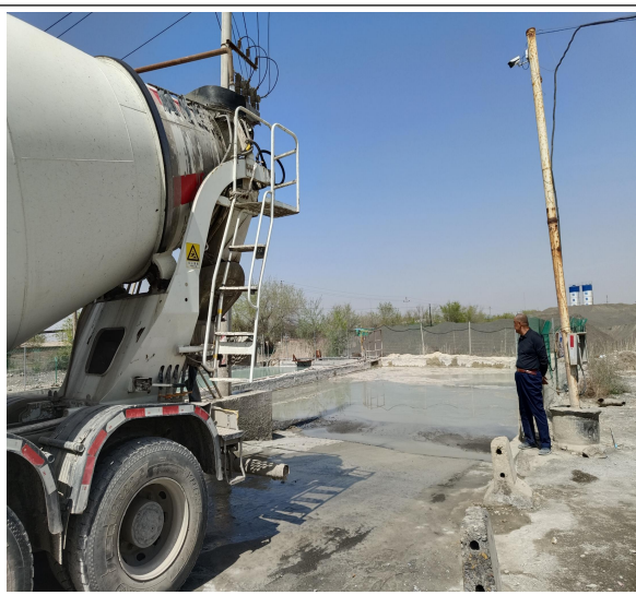
原有工程沉淀池
