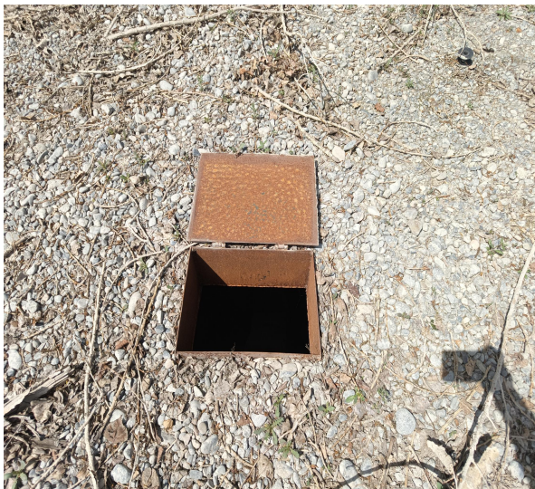
原有工程化粪池
