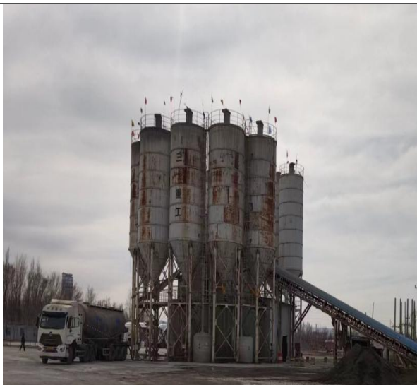
原有工程原料筒仓及除尘器
