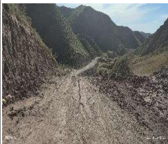
项目井场周边道路现状
