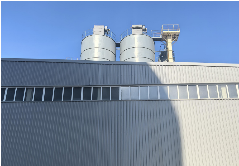
项目已建设 1#ALC 车间
