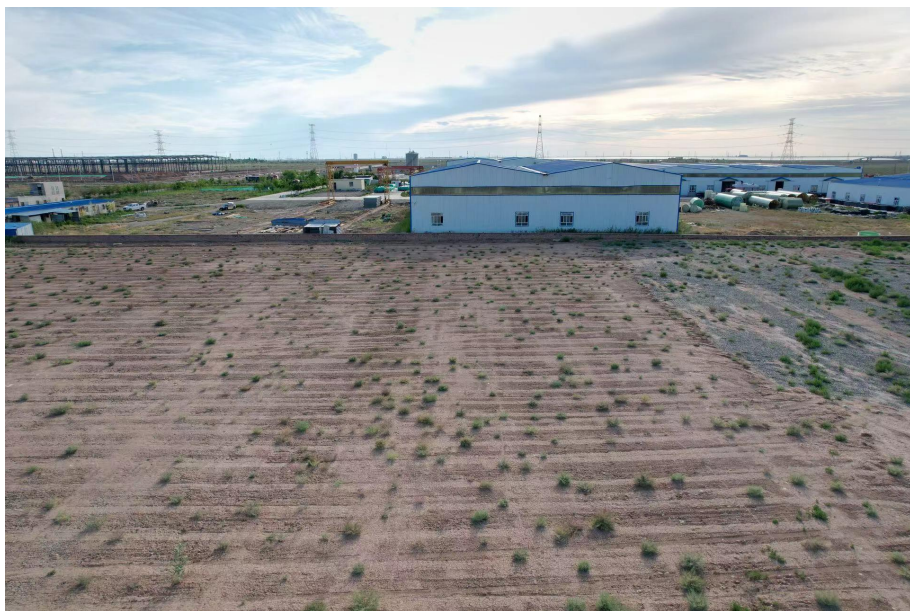
项目西侧旺源衡器公司
