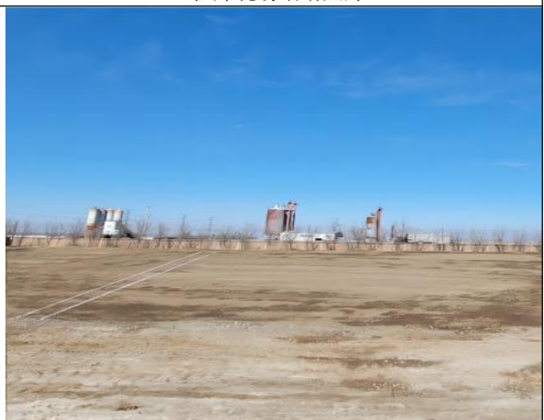
本项目拟新建危废贮存池场地
