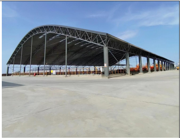
现有危废贮存池
