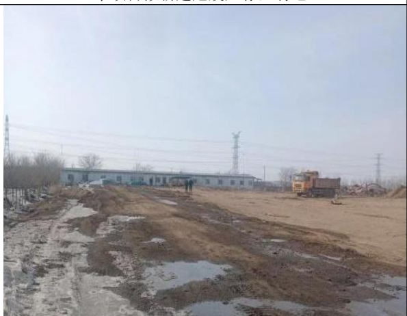
本项目拟新建危废贮存池场地
