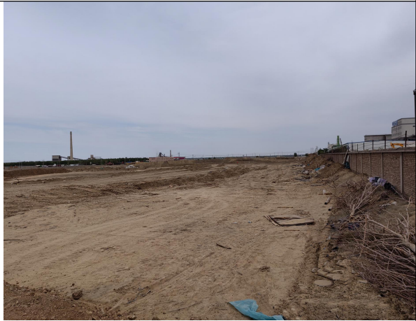
本项目拟新建危废贮存池场地
