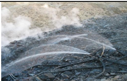
图 2.4.2-1 火区地表注水
