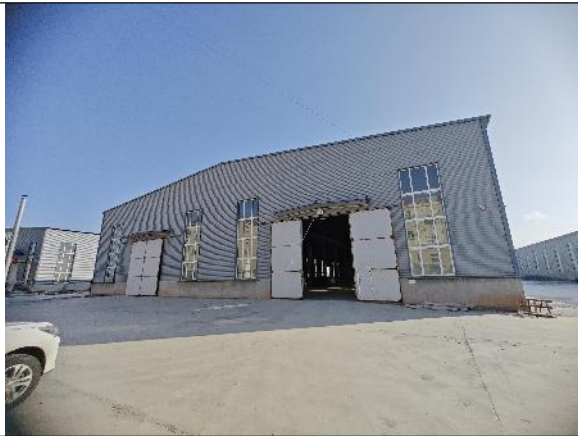
项目区东侧空置厂房
