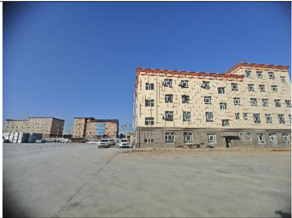
项目区北侧办公楼
