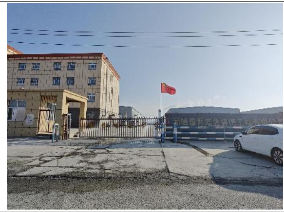
项目西侧新疆盛世宏业装饰工程有限公司
