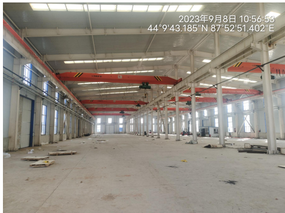
项目区厂房内部
