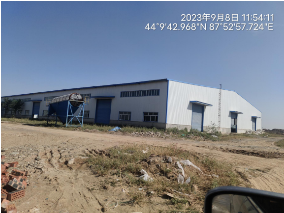
项目区东侧空置厂房
