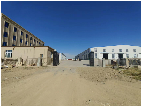
项目区西侧进厂道路
