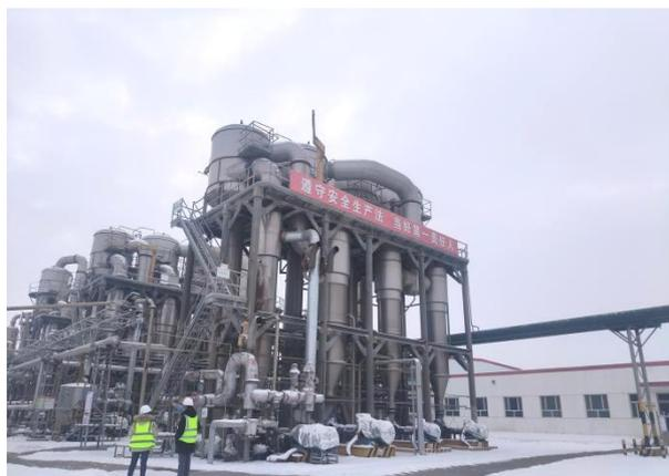
拟建 MVR 预蒸发系统东侧-蒸发器
