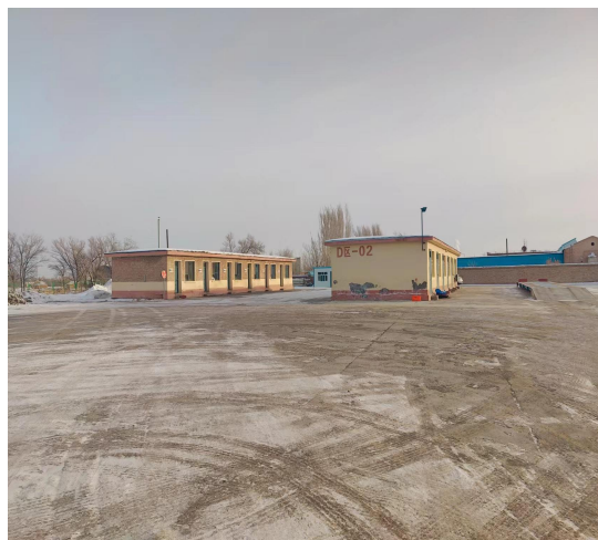
一期工程办公生活区
