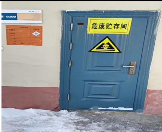
一期工程危废暂存间外
