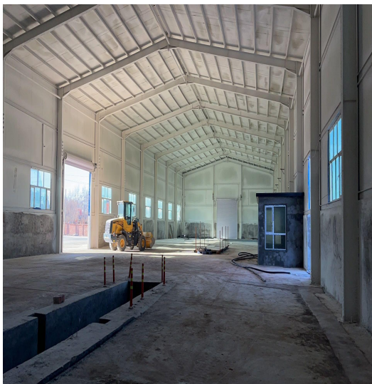
租赁厂房内现状
