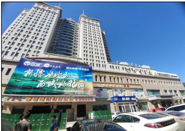
东南侧昌粮大厦
