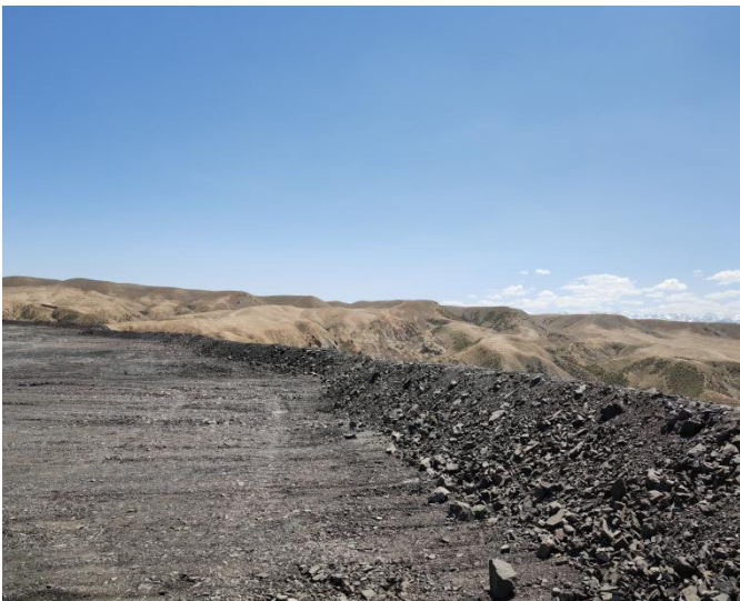
挡水坝后排渣场
