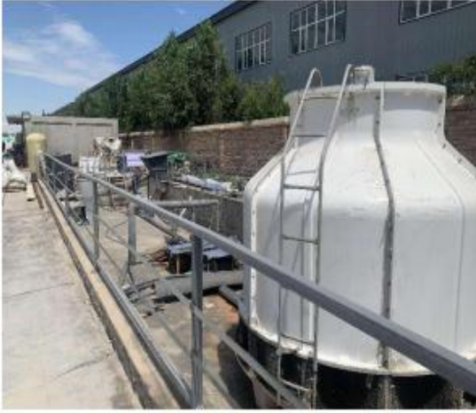
循环冷却水池
