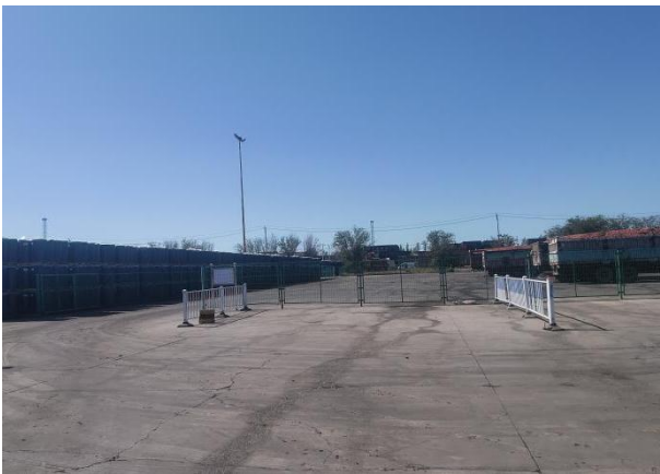
拟建项目南侧-原料堆场
