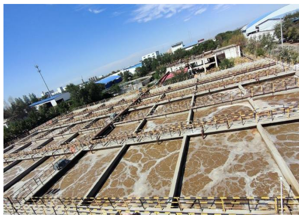
现有污水处理站
