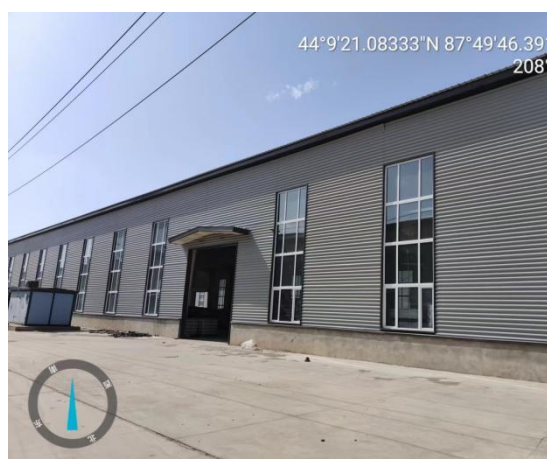
依托生产车间现状
