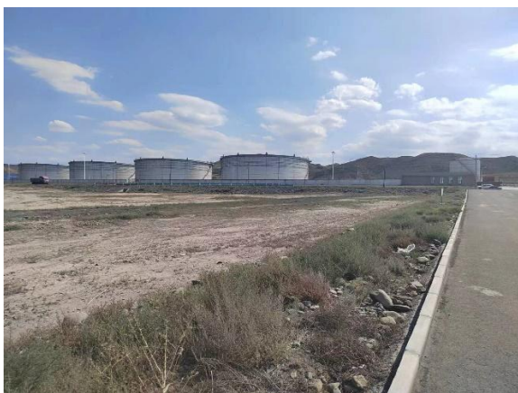
项目南侧-新疆宝明矿业有限公司油罐区
