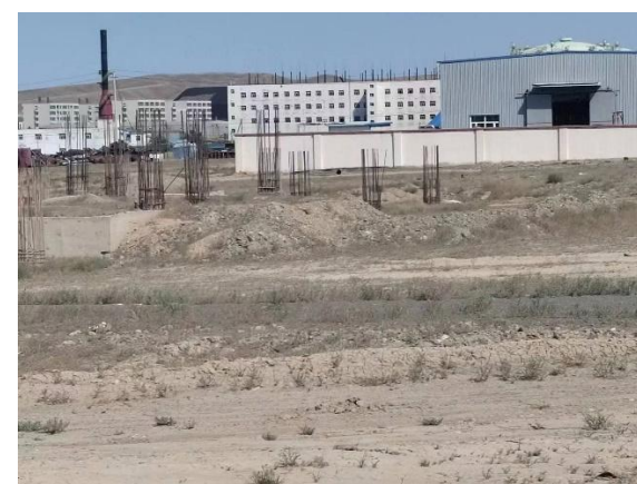
项目东侧-新疆宝明矿业有限公司厂房
