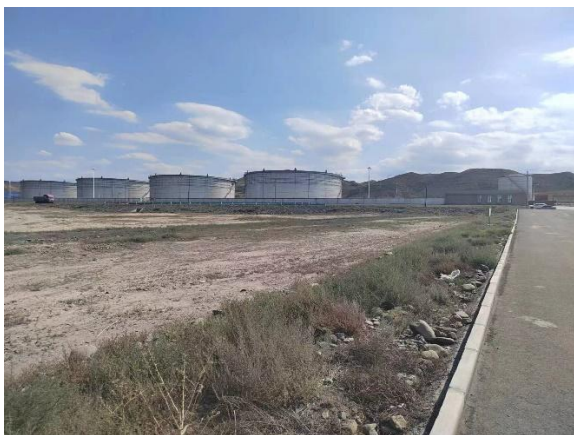
项目南侧-新疆宝明矿业有限公司油罐区
