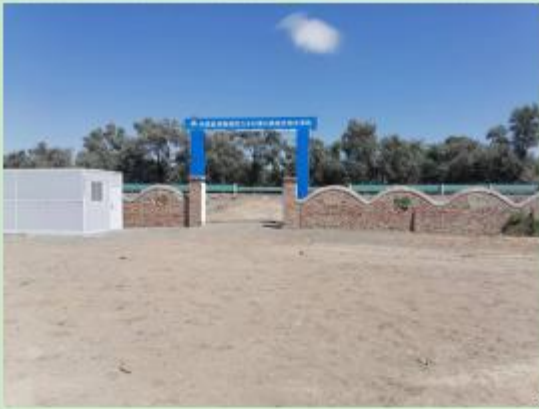
项目区东侧玛北公路
