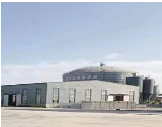
项目区西侧新疆鹏业节能科技有限公司厂房
