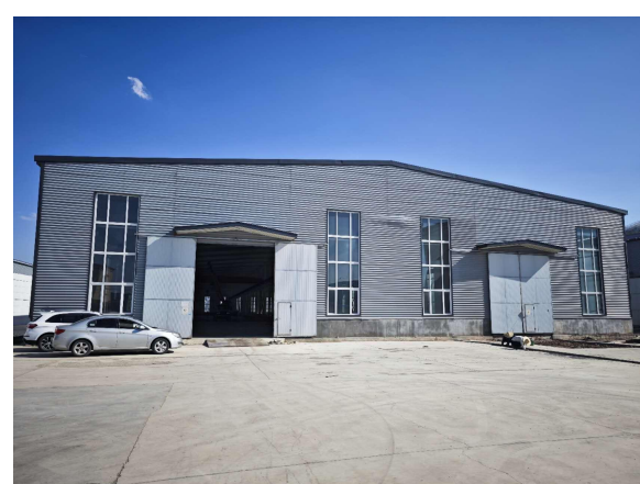
项目区北侧厂房门口
