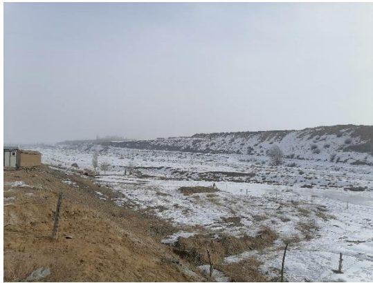
贡拜沟水库输水管道
