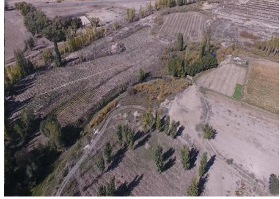
东大龙口水库至乌奇公路管道起点
