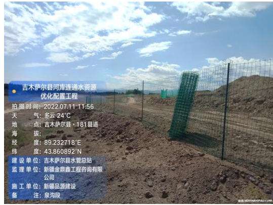
部分施工区采用纱网、彩条旗或铁网栅进行施工范围划定
