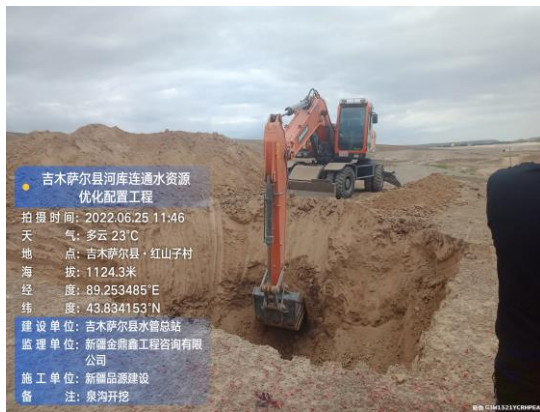
施工开挖现场
