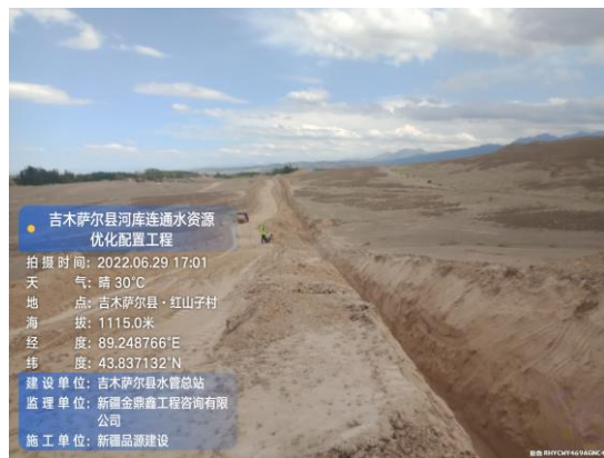
初步完成开挖的管沟
