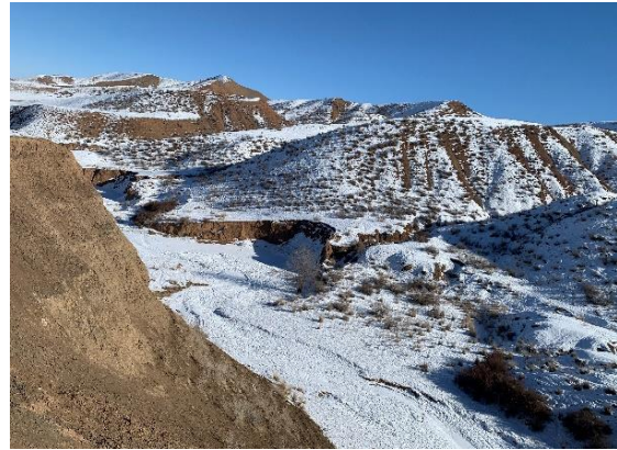
泉沟水库到乌奇公路管道起点
