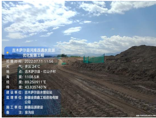
部分施工区采用纱网、彩条旗或铁网栅进行施工范围划定
