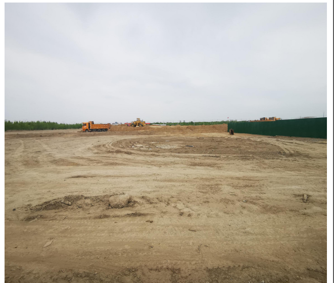
项目区北侧空地
