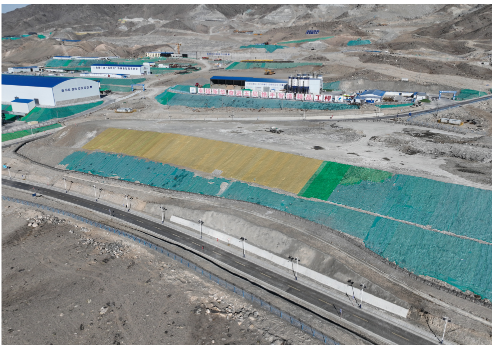
新疆布尔津抽水蓄能电站工程-施工生产生活区 （边坡临时苫盖）
