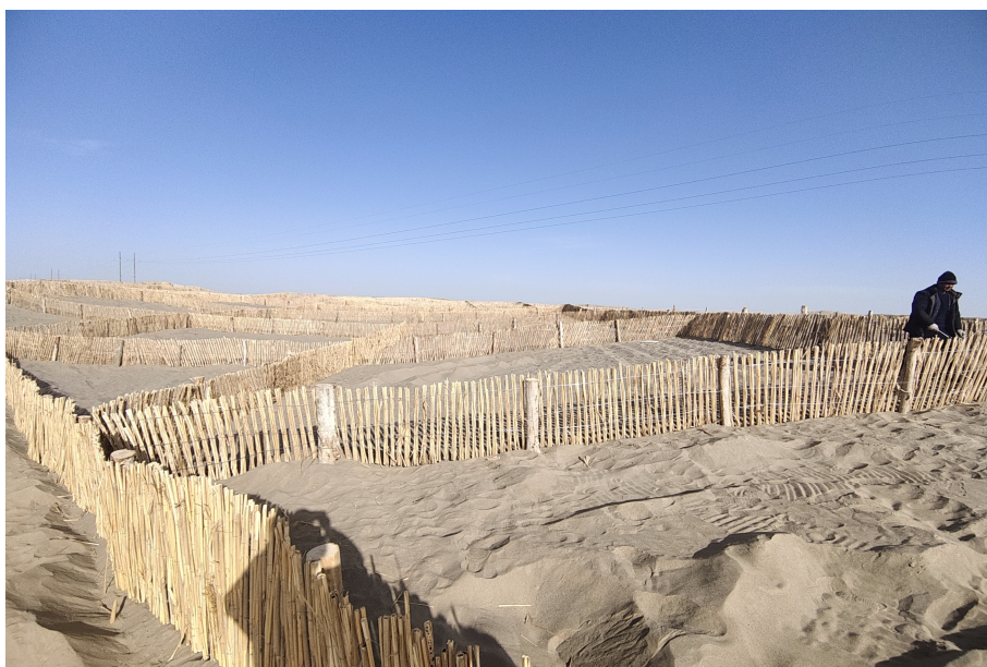
若羌县塔什萨依河干渠下游防风固沙水土保持治理工程（一期） （草方格）
