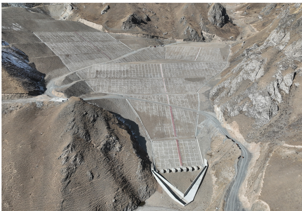
G0711乌鲁木齐至尉犁高速公路建设项目 （弃渣场工程措施防护）
