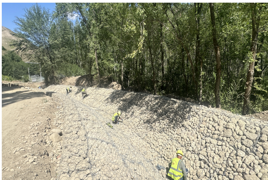
巩留县库尔德宁镇塔斯布拉克沟-海子沟小流域综合治理提质增效项目 （护岸）
