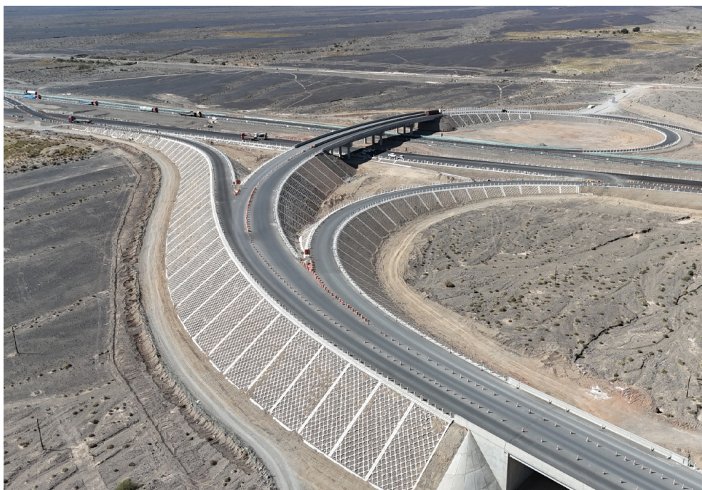
G30连霍高速公路哈密至吐峪沟段改扩建工程 （交叉工程区方格网护坡）
