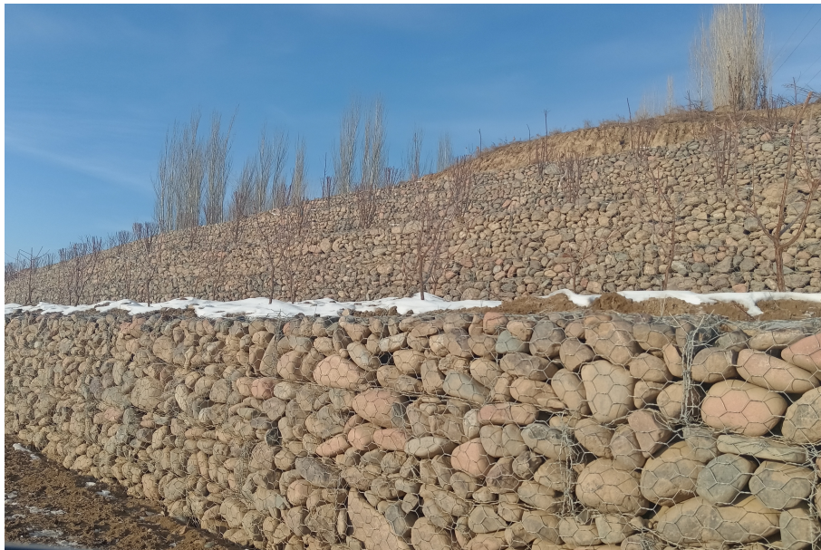
伊宁市英也尔镇南台子沟小流域综合治理提质增效项目 (高边坡治理及种树)
