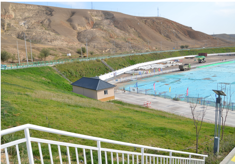
中煤伊犁2×66万千瓦热电联产项目 （植物措施）
