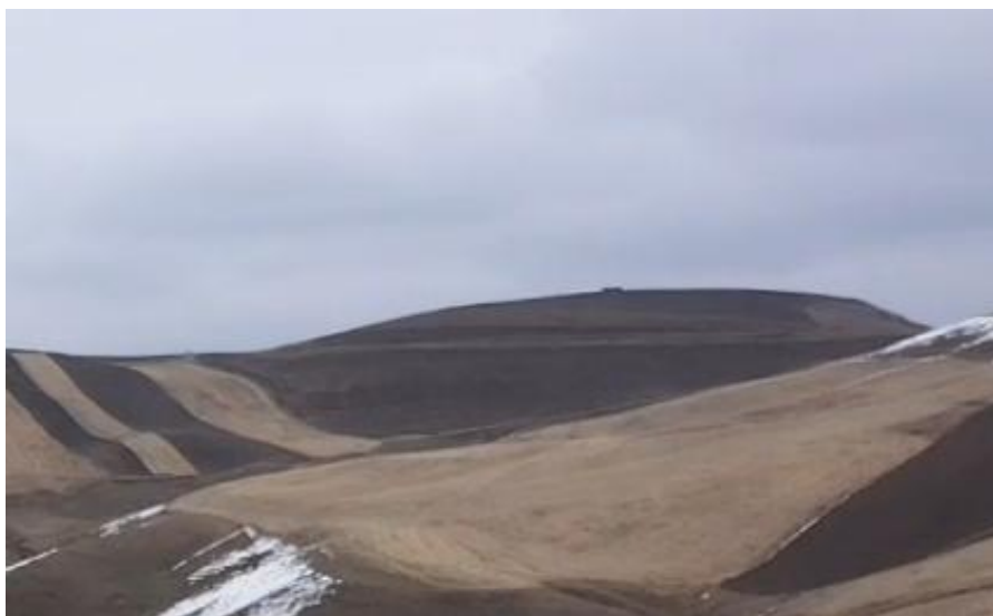
图 1-3-4 拟建废石场场地
