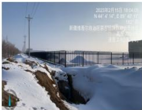
项目区南侧在建厂房
