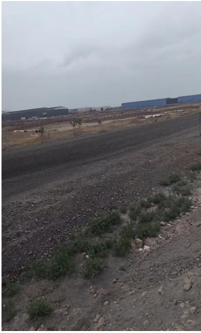
东南侧在建煤炭加工企业
