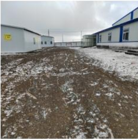
医疗废物暂存间
