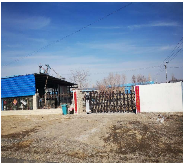
项目区出入口
