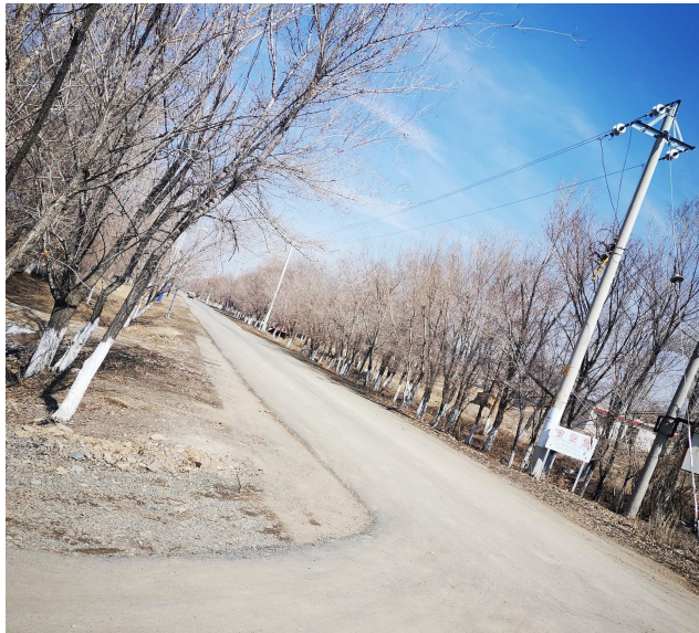
项目区西侧乡村道路
